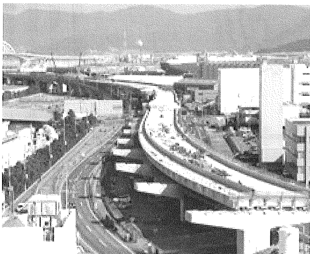
写真2 工事の進捗状況
