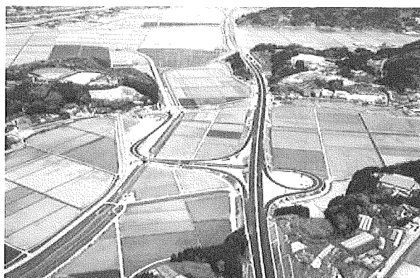
写真2 整備が進む三陸縦貫自動車道
