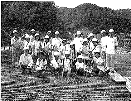
写真3 親子見学会（貝谷高架橋（仮称））
