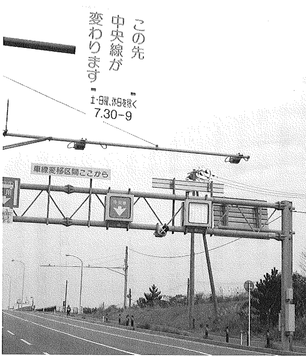
写真2 県道16号新潟亀田内野線
