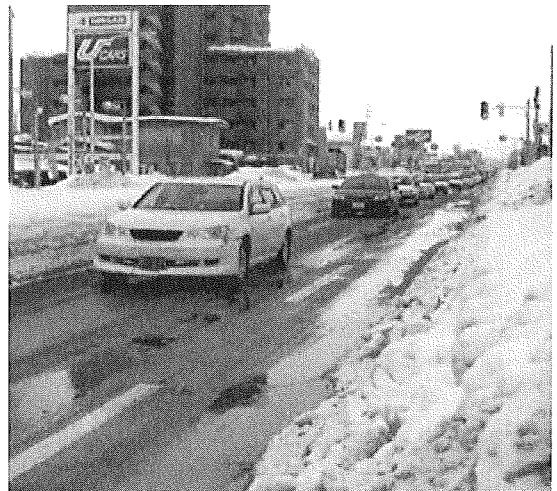
左の写真は、雪が車に踏みつぶされてできる圧雪路です。こうなると、なかなか自然に雪は溶けません。車の走行にも支障をきたしますし、渋滞の原因にもなります。
