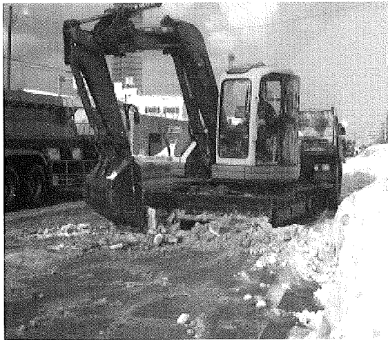
左の写真の圧雪路では、固くて重い雪の塊をバックホウではぎ取り、ダンプ車で雪捨て場に運んで除雪を行いました。 右の写真の生活道路では、ドーザー車により雪を集めて、ダンプで雪を運びました。1人佇んで除雪作業を見つめる市民の期待を込める視線が気になります。
