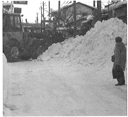
左の写真の圧雪路では、固くて重い雪の塊をバックホウではぎ取り、ダンプ車で雪捨て場に運んで除雪を行いました。 右の写真の生活道路では、ドーザー車により雪を集めて、ダンプで雪を運びました。1人佇んで除雪作業を見つめる市民の期待を込める視線が気になります。
