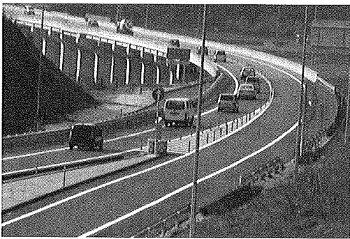
写真1 下岡高架橋 (香住道路)
