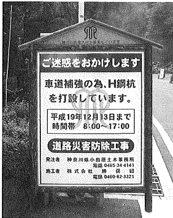
写真4 木製道路工事表示看板
