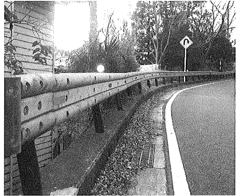
写真1 神奈川県型木製ガードレール
