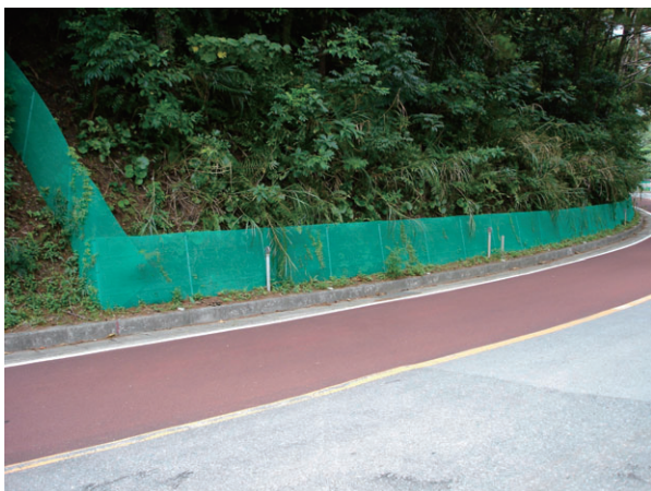
写真-3 クイナフェンス設置状況
