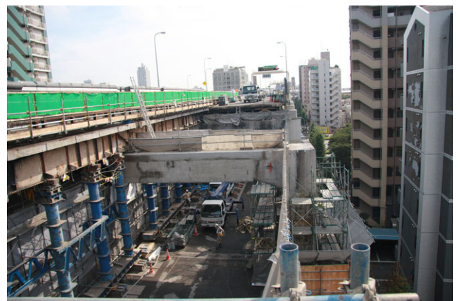
写真－4 上層主桁・床版撤去状況
