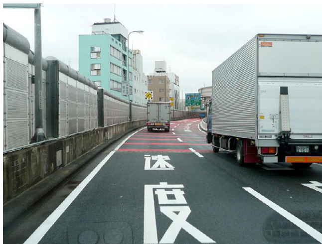
写真－８ 安全対策の１例（カーブ手前カラー舗装）
