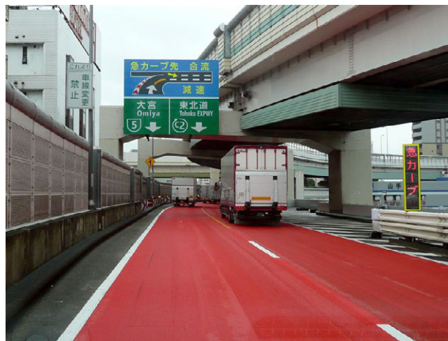
写真－９ 安全対策の１例 (カーブ部滑り止めカラー舗装・注意看板・ＬＥＤ表示板)
