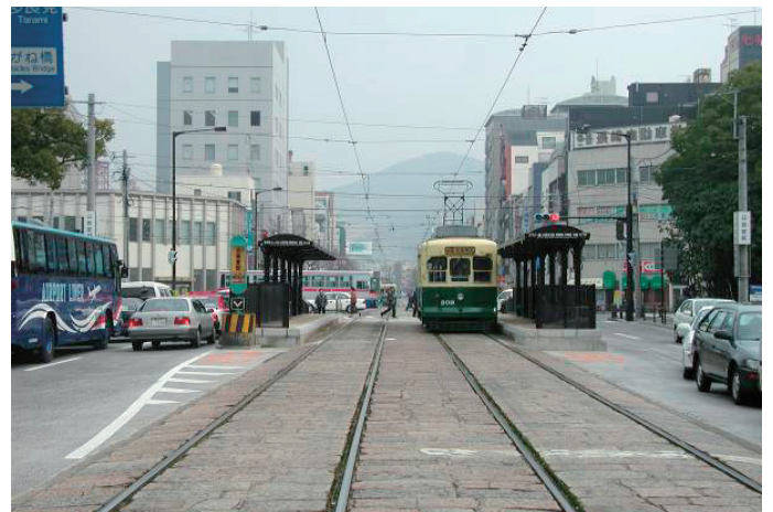
歩道橋撤去後
