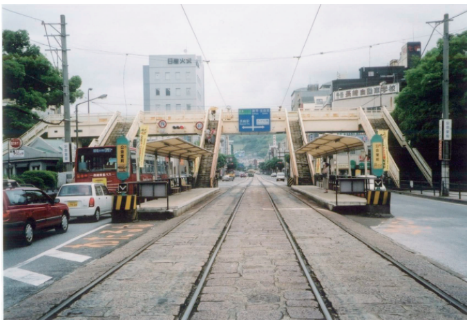
歩道橋撤去前
