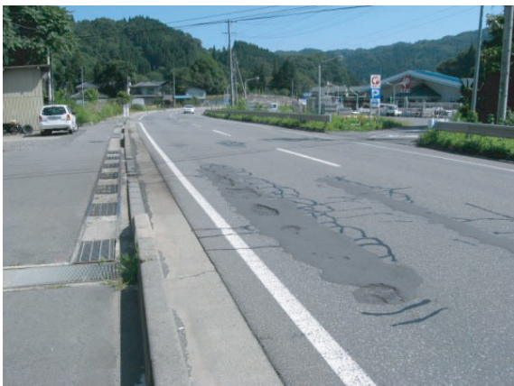
舗装損傷箇所の舗装打換
