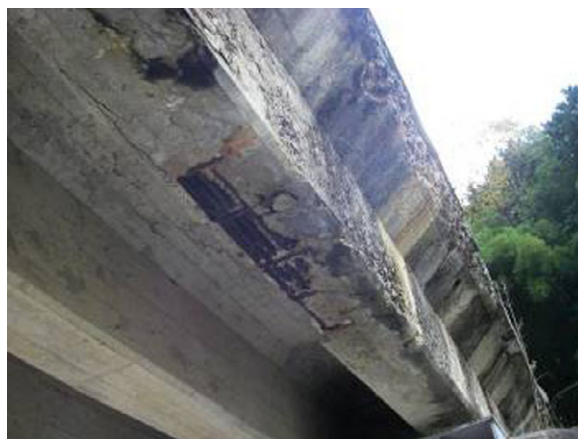
桁の損傷がみられる橋梁
