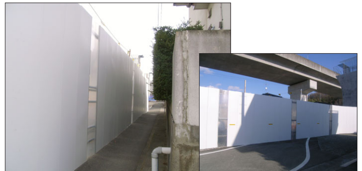
写真-5 住宅地周辺の狭い間隔のスリット(透明板)
