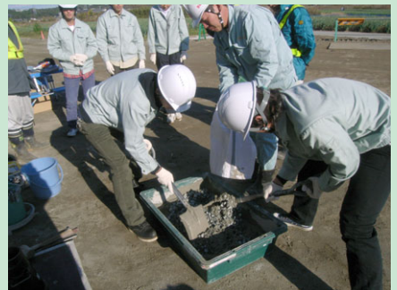
コンクリートをつくる
