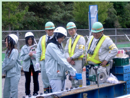
レンチによる橋桁のボルト締め
