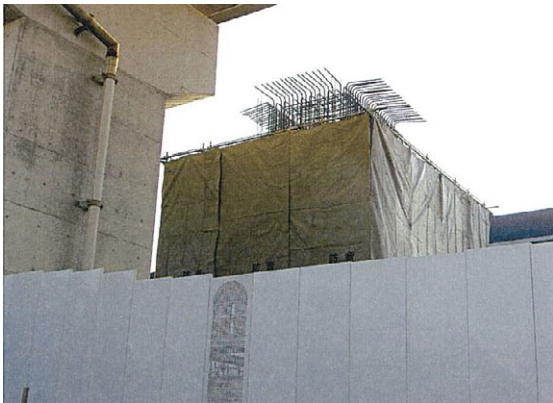
写真-6 足場をシートで囲っている様子
