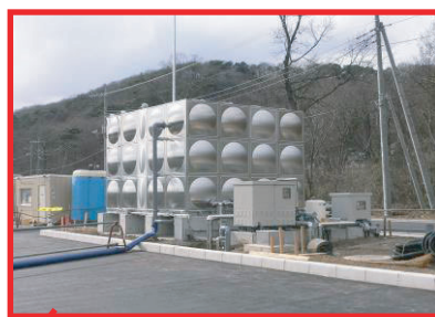
○給水タンク(飲料用)
