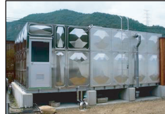
○飲料水貯水槽
