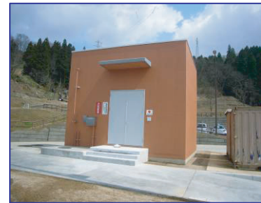
○ 非常用発電装置
