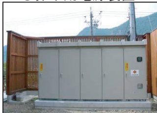
○非常用電源装置
