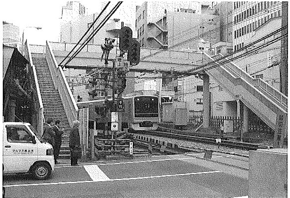
写真9 電車通過が頻繁で渋滞していた道路状況(上)と人道跨道橋がある「新宿第2号踏切」(下)
