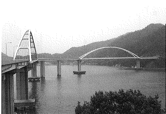
写真3 内海大橋 (ニールセンローゼ橋 橋長：832 m)
