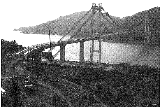
写真6 豊島大橋(仮称) (吊橋 橋長：909 m)
