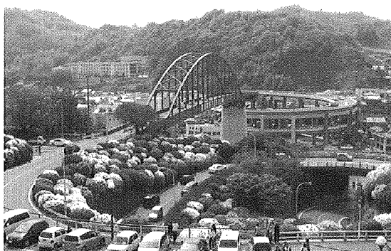
写真2 音戸大橋 (ランガー橋 橋長：700 m)
