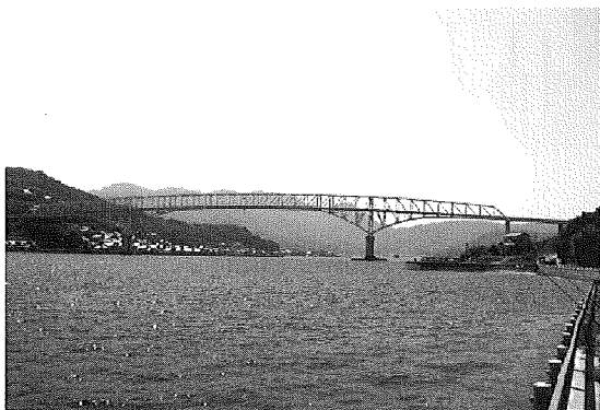
写真4 早瀬大橋 (トラス橋 橋長：623 m)
