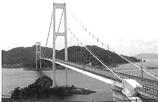
写真1 安芸灘大橋 (吊橋 橋長：1,175 m)
