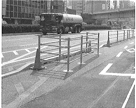
写真24 駐停車の注意標識と沿道のレンタカー会社への出入口、柵、縁石等整備されていた
