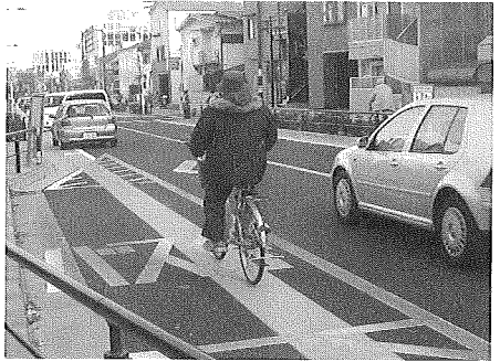
写真8 バス停(バスベイ)と重複している自転車レーン、バス停車時のレーン走行は困難です
