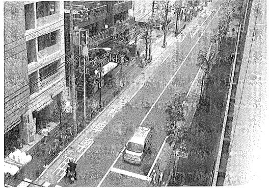
写真5 渋谷区幡ヶ谷地区での整備(遠景)
