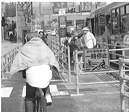
写真23 バス停留所は防護柵で完全分離され、停留所から歩道への出入りは自転車道を横断するスタイルとなっていた。自転車走行者には路面表示と標識で一時停止を認識させていた。停留所から歩道への横断もスムーズに行われており、特に支障は見受けられなかった
