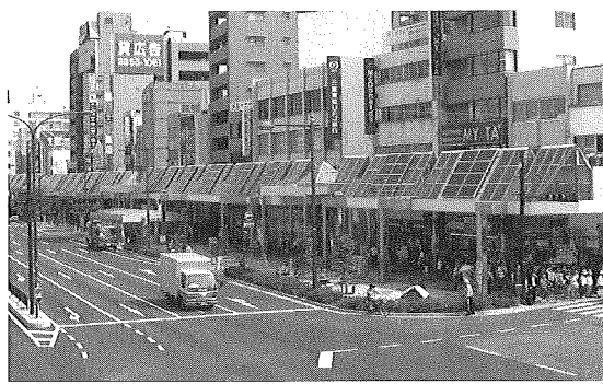
写真1 ソーラーパネルを屋根の一部にして設置されたアーケード
