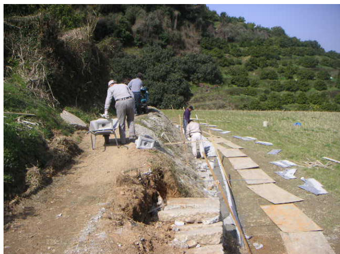
写真(8) 平成20年度笠畑地区 工事途中 2/3
