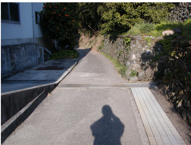
写真(5) 平成19年度方南地区 着工前 1/2
