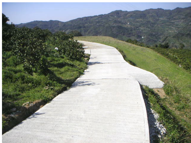
写真(9) 平成20年度笠畑地区 竣工 3/3
