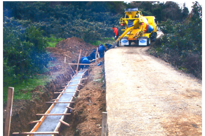
写真 (2) 施工途中 2/4
