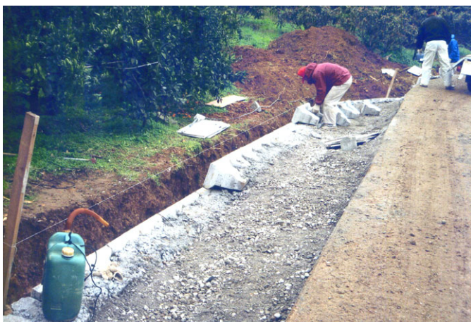
写真 (3) 施工途中 3/4
