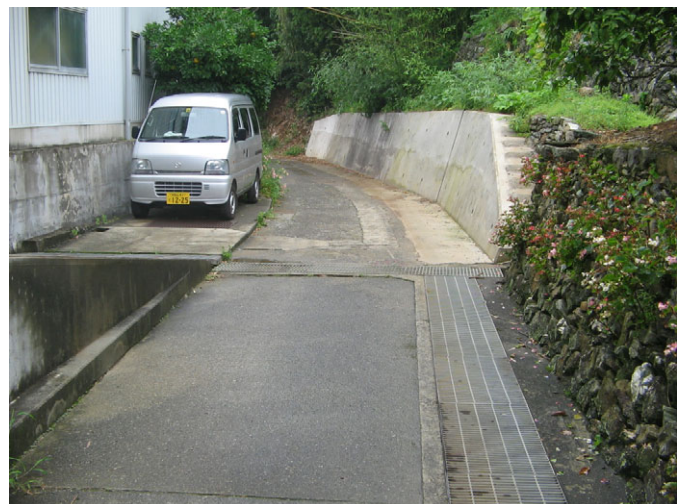
写真(6) 平成19年度方南地区 竣工 2/2
