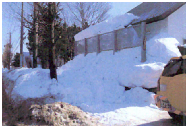
写真3 屋根雪が歩道上に落ちたところ
