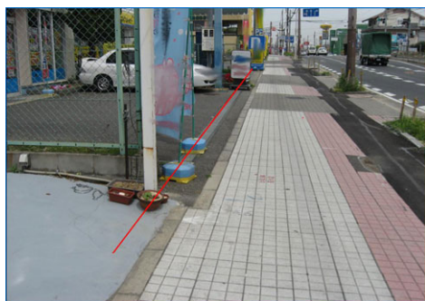
官民境界（赤線）通りに構造物が設置されていない例
