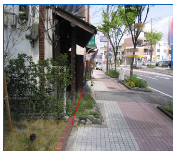
道路敷地が不法占用されている例
