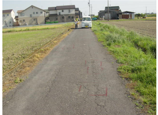
劣化が進んだタール舗装
