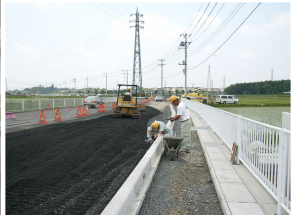
■市道改良工事
