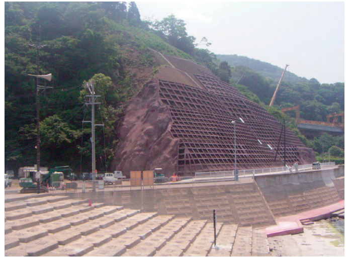
復旧完了写真
