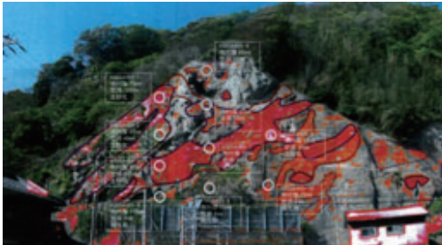
緊急道路防災調査状況
