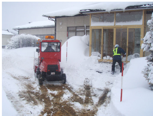
除雪作業中の写真（乗用）
