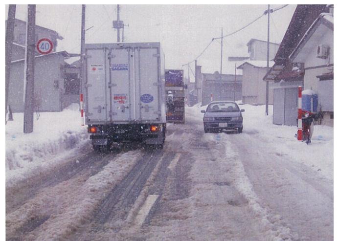
洗濯板状の路面
