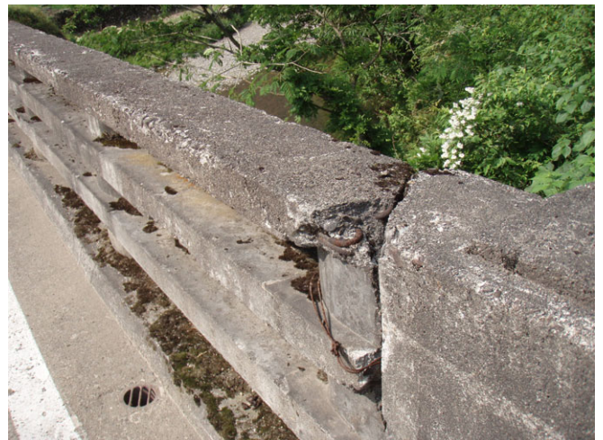
高欄の破損状況
