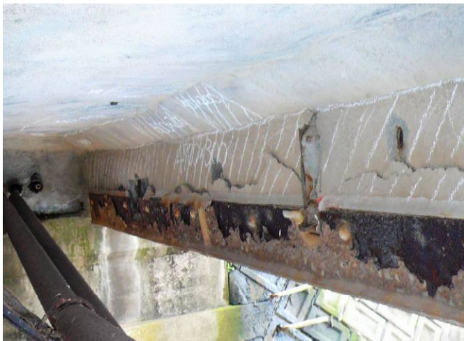
主桁の損傷状況
