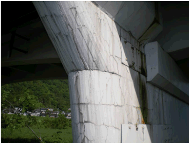
橋脚の損傷状況（ひび割れ）
