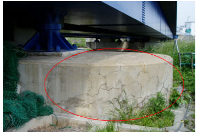
亀甲状のひび割れ（アルカリ骨材反応）
