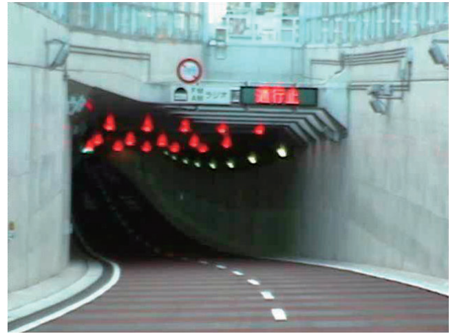
写真-6 坑口部のフラッシング点滅状況
