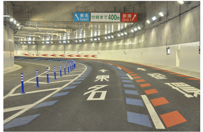
写真-14 大橋ジャンクションの色による走行支援対策
