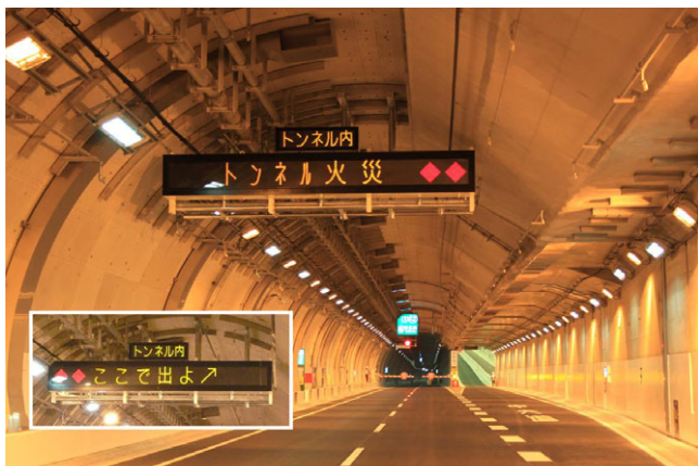
写真-3 トンネル内警報板
