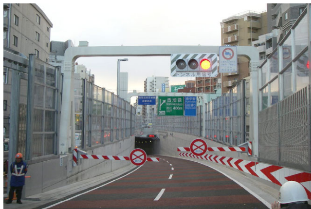
写真-4 トンネル用信号機・遮断機
