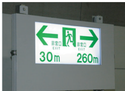
写真-9 非常口誘導表示灯
