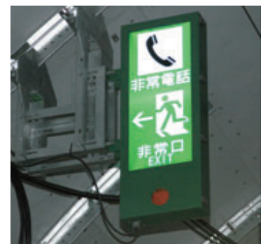
写真-10 非常口表示灯
