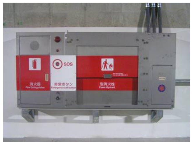
写真-2 消火器・泡消火栓・給水栓・押しボタン式通報装置
