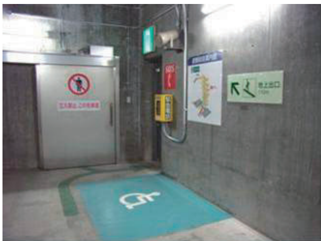
写真-12 非常口内部の状況
