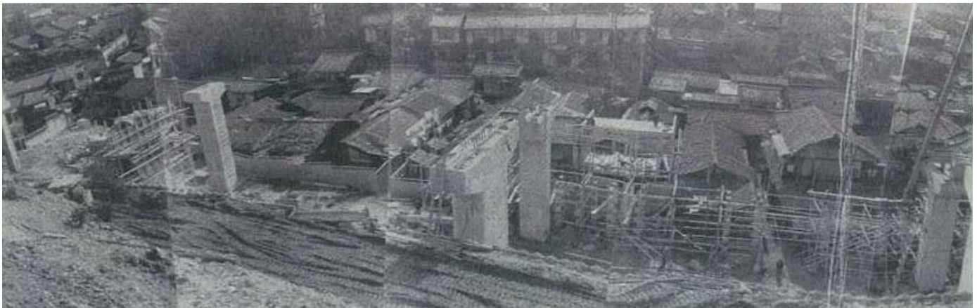
桁架設前の状況（昭和42年1月）
