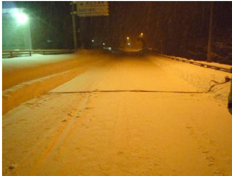
1 台体制除雪実施時 有効幅員：6.1m
