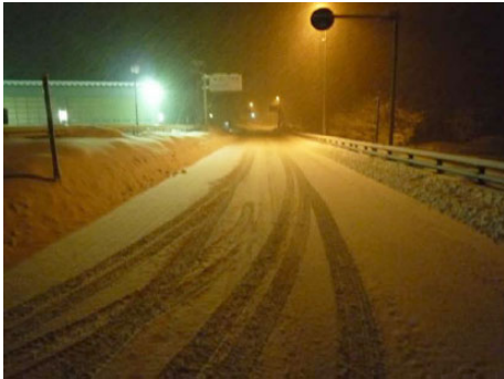
2 台体制除雪実施時 有効幅員：6.7m
