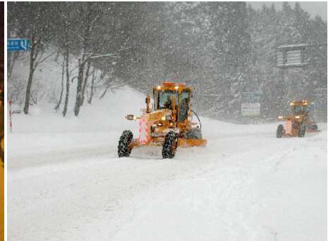
除雪状況（2 台体制）
