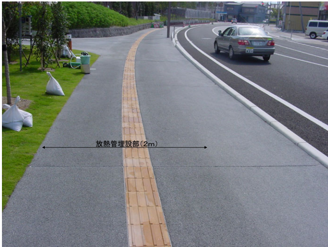
図4 冷却舗装日射部
