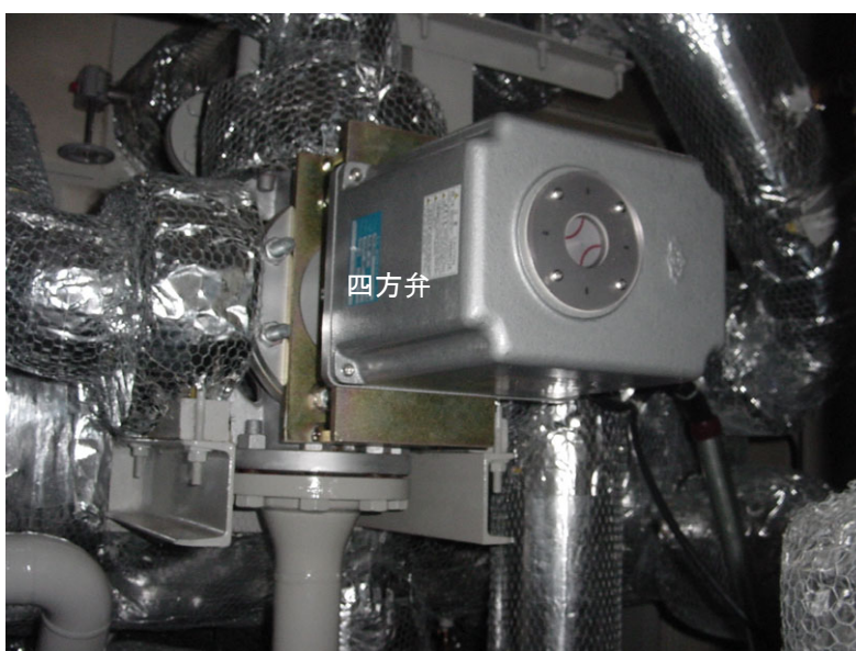
図 17 逆回転を可能にする四方弁
