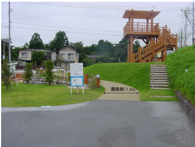
図6 冷却舗装園路部
