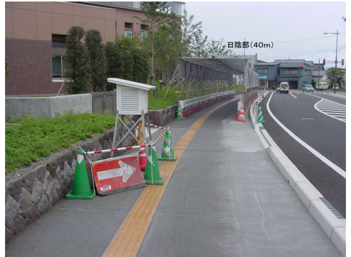
図5 冷却舗装日陰部
