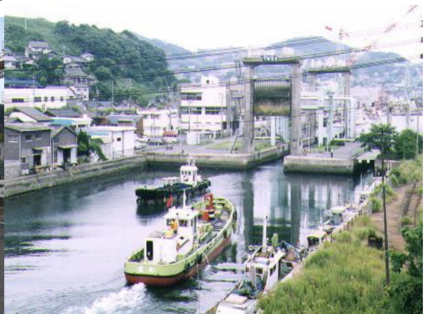
下関漁港閘門と水門
