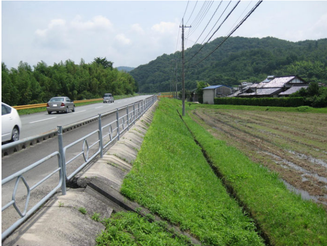
写真 3 草刈り前の法面
