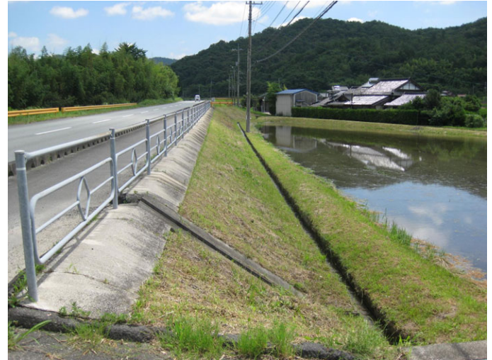
写真 4 草刈り後の法面
