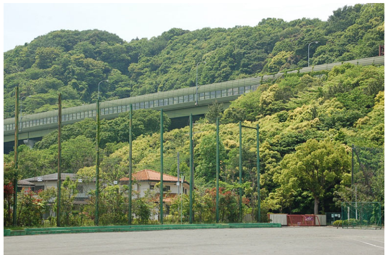
写真-7 釜利谷第二高架橋（現在）
