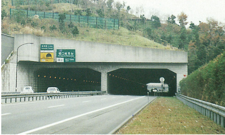
写真-1 整備後（平成9年）
