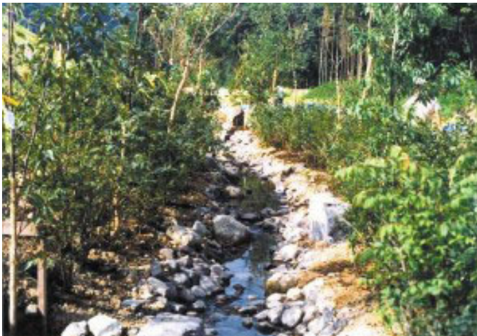
写真-3 整備時（平成2年）
