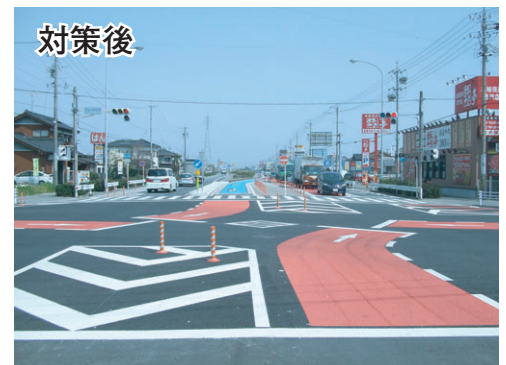
▲写真-1 右折レーンの正対化（国419号 愛知県高浜市神明町）
