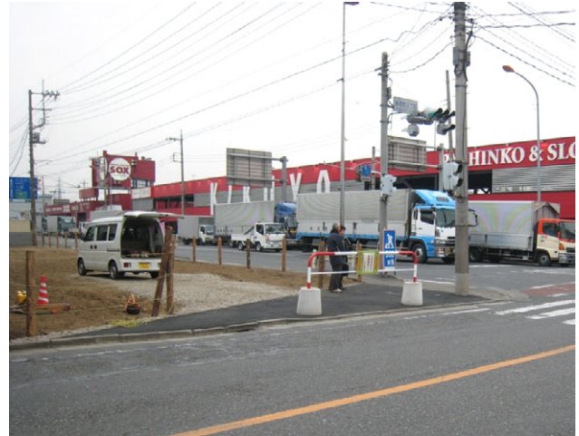
写真5 対策後 (撮影：H21.12)
