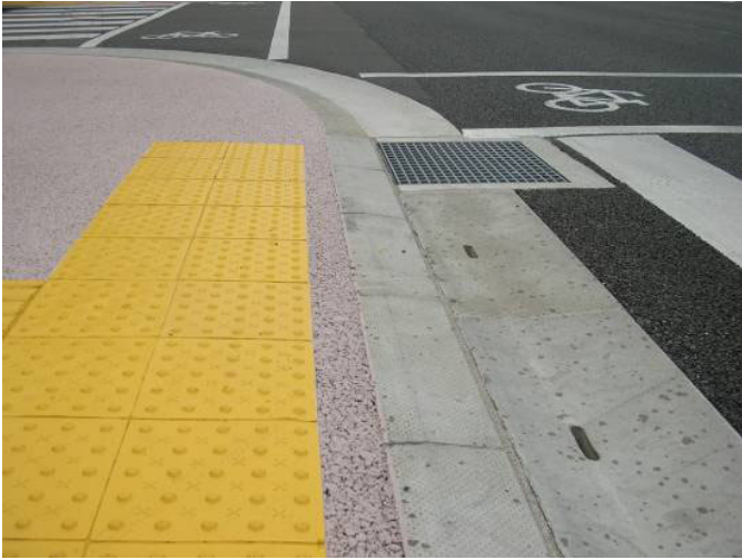
段差解消ブロック設置例 1
