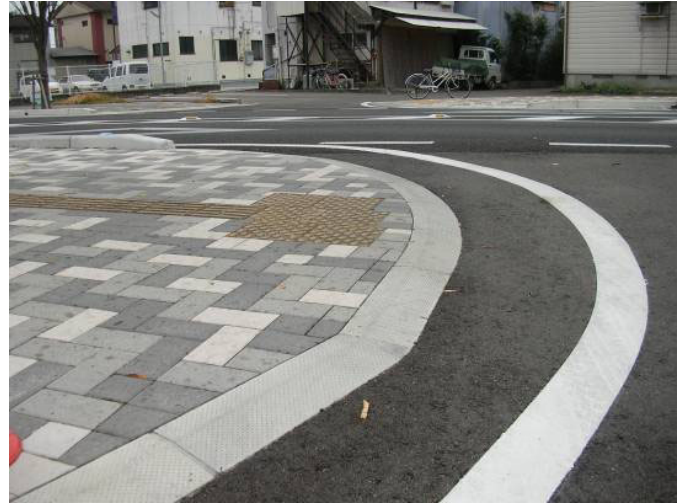
段差解消ブロック設置例 2
