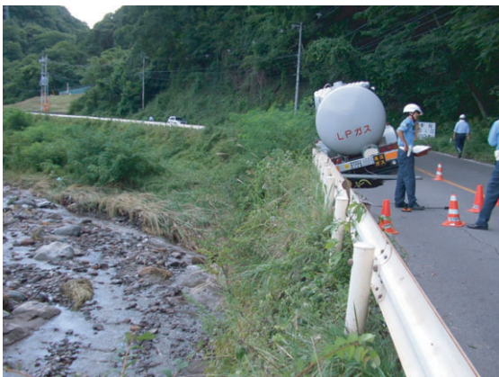
路面下の空洞による陥没事故
