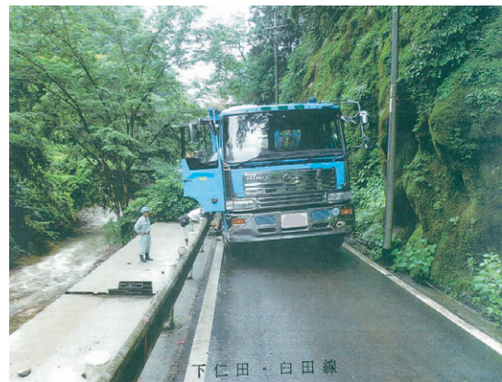
路面下の空洞による陥没事故
