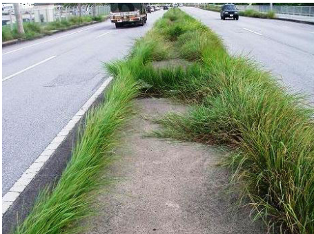
【写真－16】 雑草繁茂の現状 1
