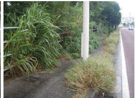
【写真－18】 雑草繁茂の現状 3
