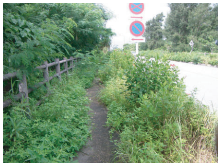
【写真-2】植栽樹の雑草繁茂 1
