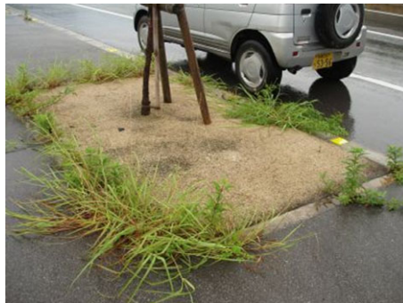
【写真－17】 雑草繁茂の現状 2
