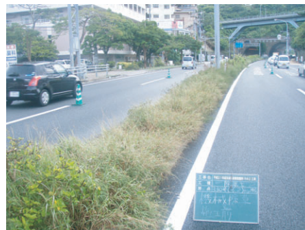
【写真-4】中央分離帯の雑草繁茂
