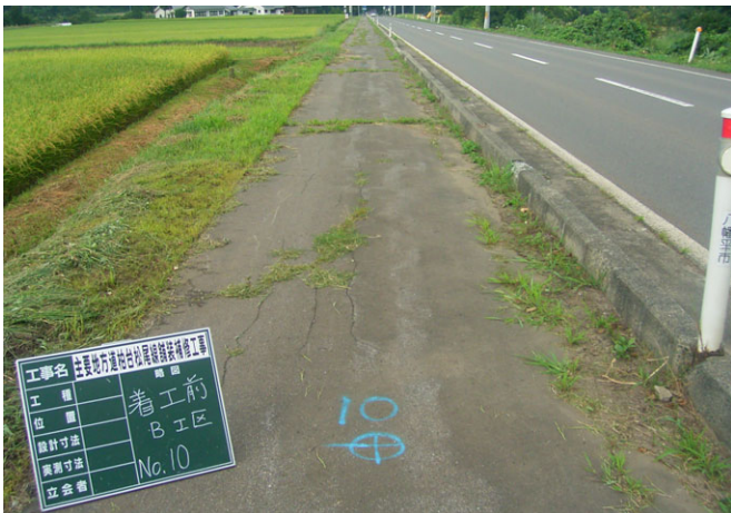
権限移譲を受けた県道（歩道）の舗装補修
