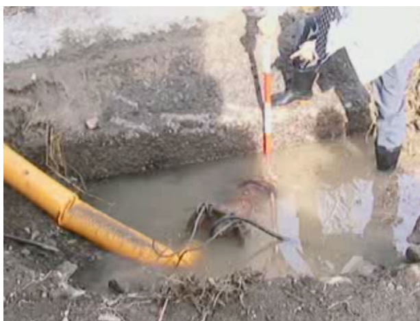
橋脚基礎下面の状況 (人力でもポールが容易に圧入される 鉛直方向に約 20cm)
