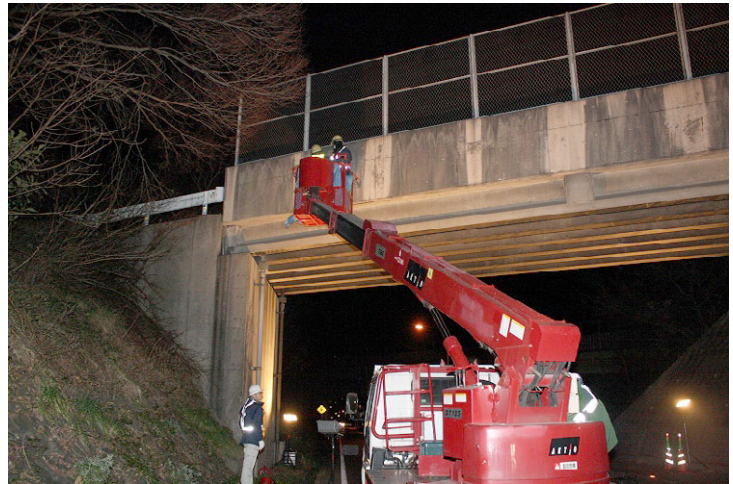
↑丸尾側道橋支援状況
