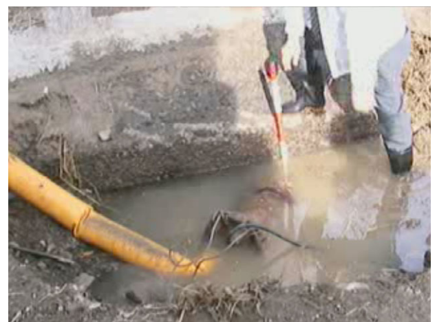
橋脚基礎下面の状況 (人力でもポールが容易に圧入される 鉛直方向に約 20cm)
