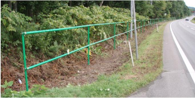
写真2 鹿飛び出し防止柵設置
