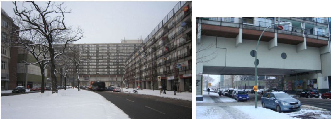
(写真9) ベルリン・パレス通の上空に設けられた社会福祉住宅
