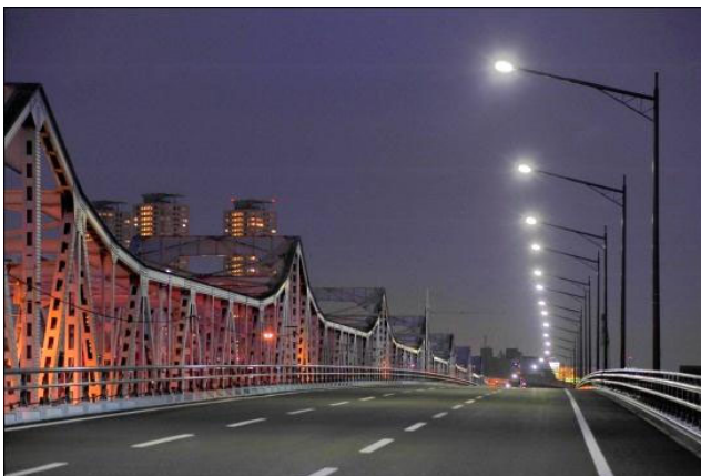
LED 設置事例 (府道大阪中央環状線・鳥飼大橋)
