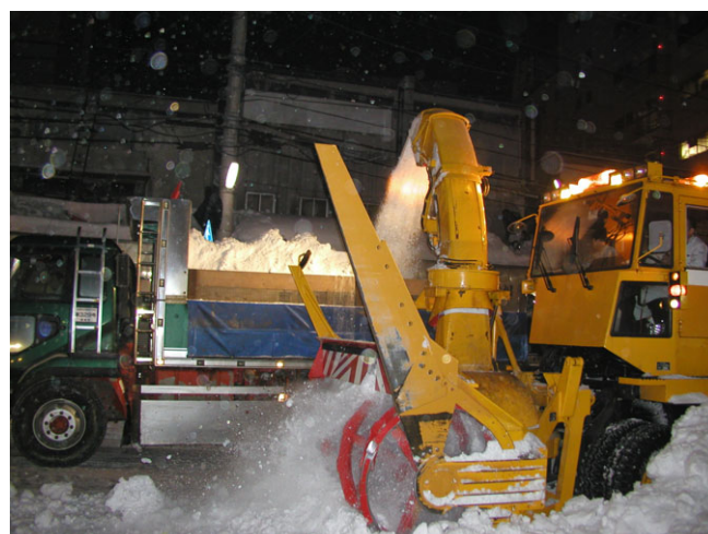
写真4 ロータリー車にてダンプトラックに積み込む作業
