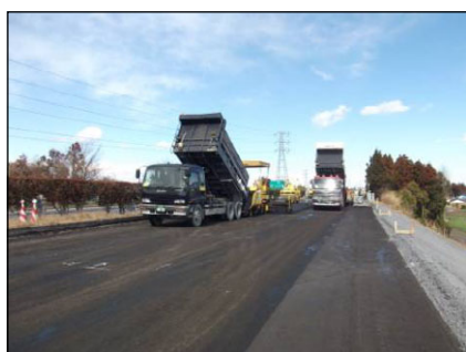
(舗装施工状況 3/16 17:00頃)
