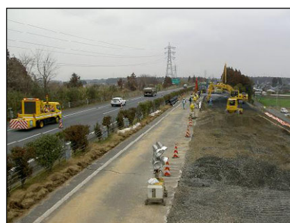
(路体・路床施工状況 3/15 13:00頃)
