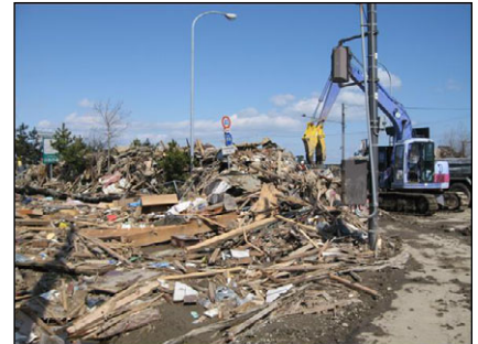
（瓦礫撤去状況）
