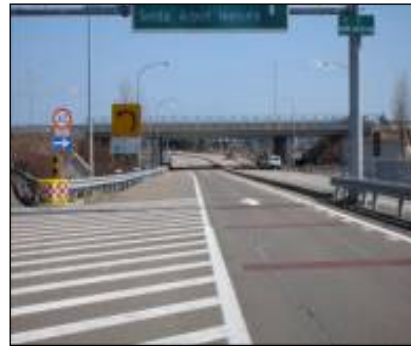
（仙台東部道路 仙台若林JCT 復旧状況）
