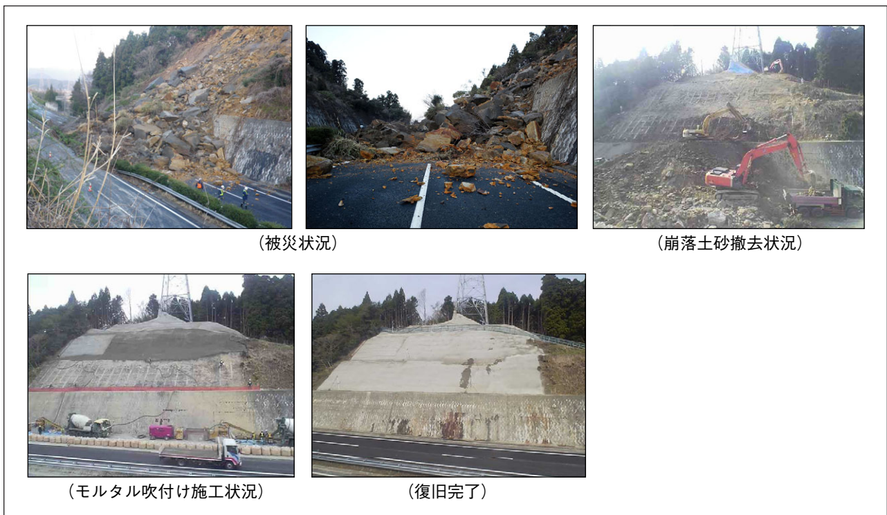
(写真③) 常磐道 いわき勿来～湯本（下り線）切土崩壊
