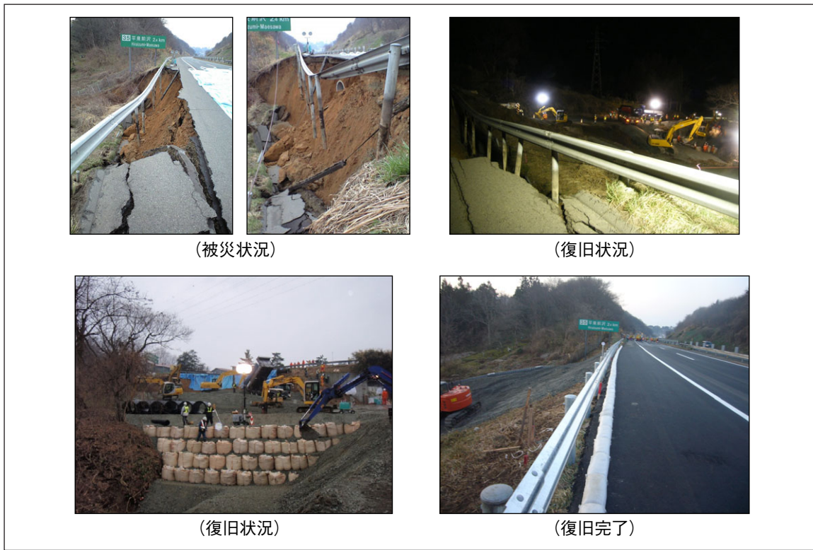
(写真②) 東北道 水沢～平泉前沢（上り線）盛土崩壊
