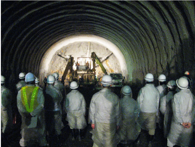
<ロックボルトの削坑状況を見学>
