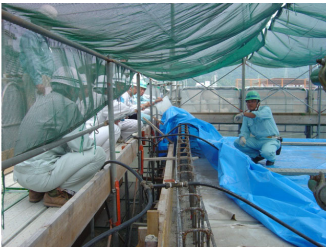
<ボックスの施工を見学>
