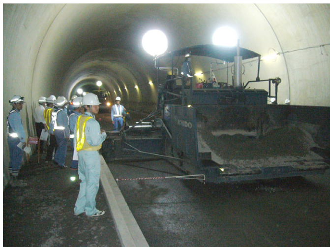
< RCCP 舗装の施工状況を見学 >
