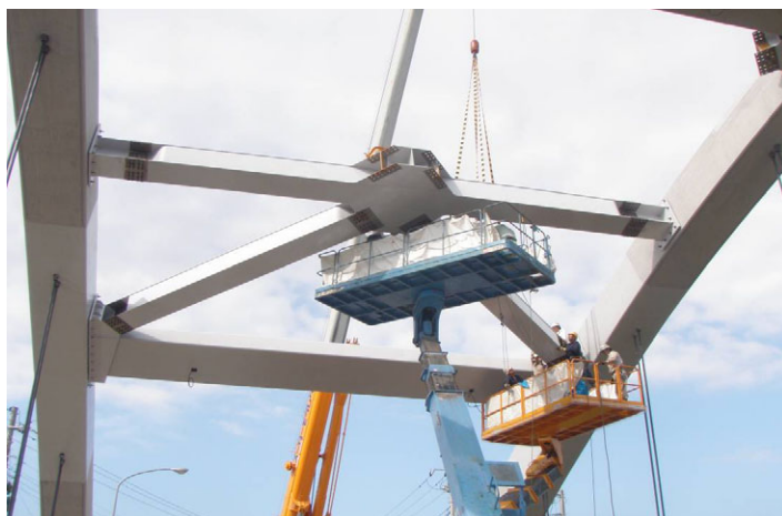
写真-5 鋼製補強部材の架設状況
