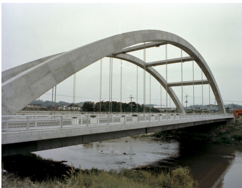
写真-1 建設時の君津新橋
