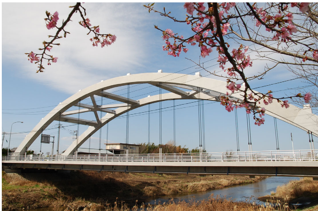
写真－8 リニューアル後の君津新橋
