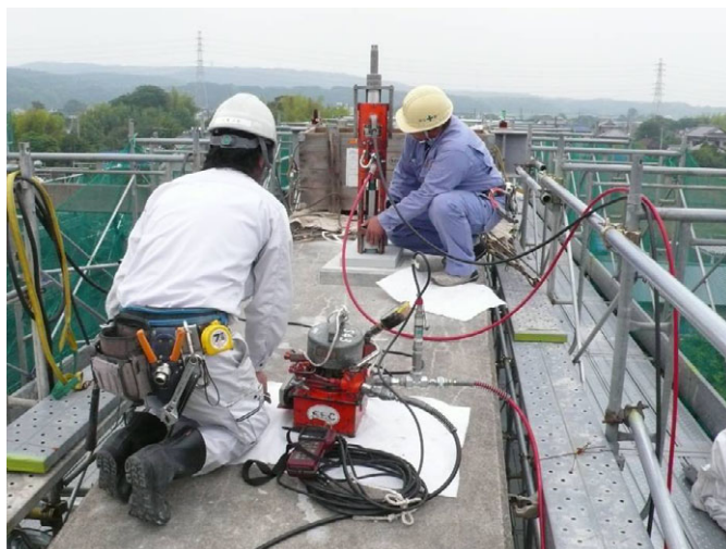
写真-4 張力調整の状況
