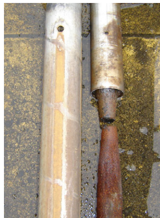
写真-2 鋼棒破断部
