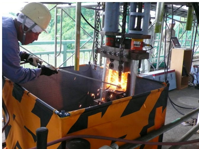
写真-3 PC 鋼棒の切断状況
