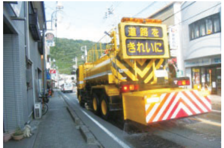
写真13 散水車による道路清掃
