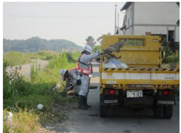
写真 19 ガレキ撤去状況
