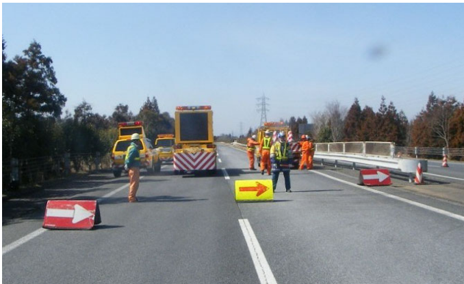
写真 14 規制作業支援状況
