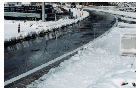
※河川水等を利用し道路面に散水し融雪
