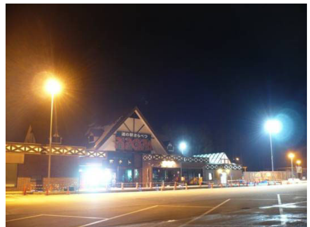
写真-1 実験箇所夜間状況-「道の駅さらべつ」
