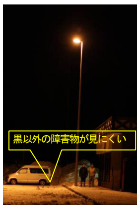
高圧ナトリウム照明
