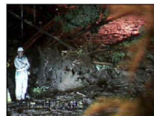
CCTV写真: 新宿側から撮影
