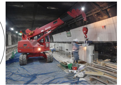
●図17-監査廊設置状況
