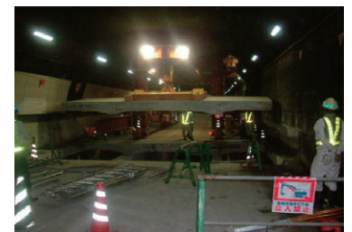
●図13-既設床版吊上撤去
