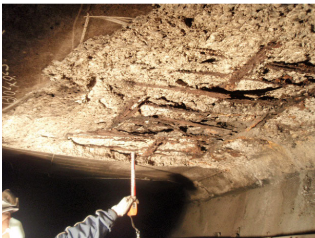
●図4—損傷状況写真（床版下面及び設備）
