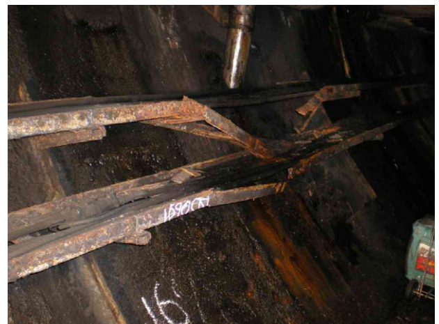
●図4—損傷状況写真（床版下面及び設備）
