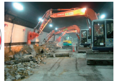
●図11-監査廊取壊し状況
