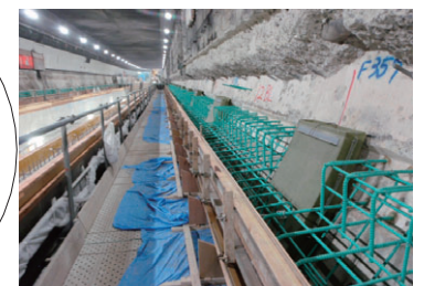
●図14-受台鉄筋・型枠構築
