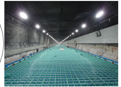
●図16-床版上鉄筋組立完了
